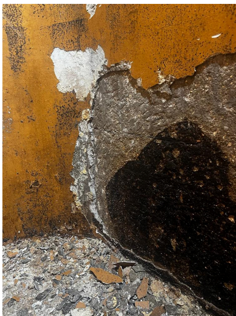
Cisterna prima della sabbiatura
